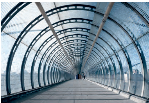
Tubo tondo Ø160, spessore 5 mm
